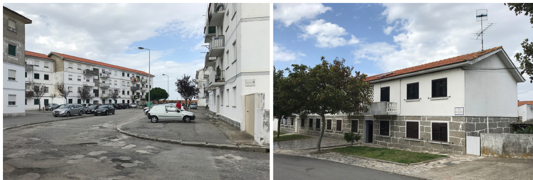
Bairro Casas de Pescadores em Matosinhos (3ª fase, 1958), Alexandre T. Bastos - 104 fogos, à esquerda GPS: 41.187778N 8.679868W Bairro Casas de Pescadores em Matosinhos (2ª fase, 1958), Alexandre T. Bastos - 56 fogos. GPS: 41.187778N 8.679868W
