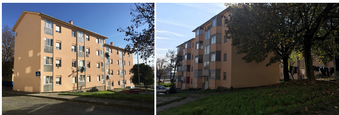
Bairro Engenheiro Machado Vaz. Vista geral da intervenção
