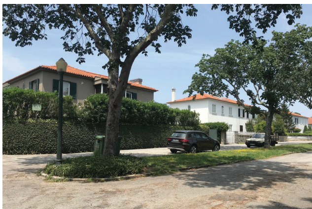
Fig. 17 Bairro de Casas Económicas Marechal Gomes da Costa [© Gisela Lameira]
