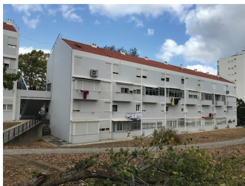
Fig. 52 e 53 Bairro de Olivais Norte - Edifícios tipo IID [© Gisela Lameira]
