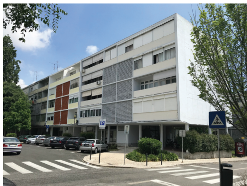
Fig. 43 e 44 Bairro das Estacas [© Gisela Lameira]
